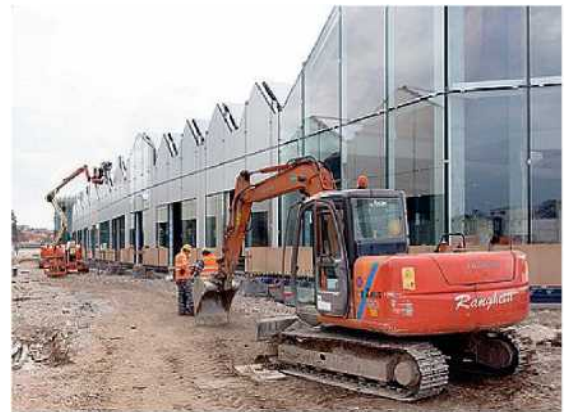
IL CANTIERE Apertura prevista in ottobre; a destra, Valentina Aprea
